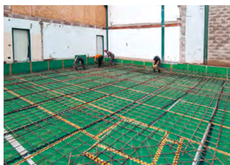
Fondazione palazzina uffici, Romano d'Ezzelino Vicenza.
